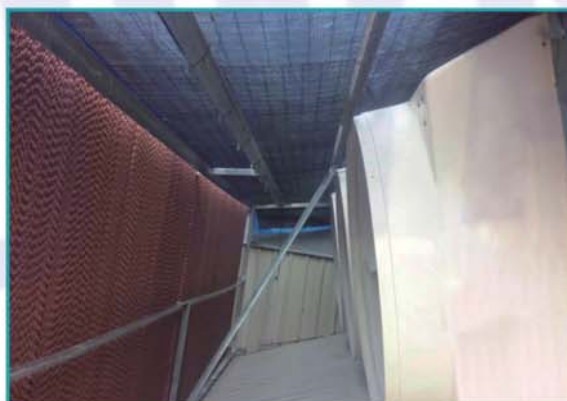
廠內粉塵,抽出後過濾水洗,排出廠外為乾淨空氣
